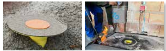
diboFLEX einbetoniert und mit Bitumenbahnen verflämmt
